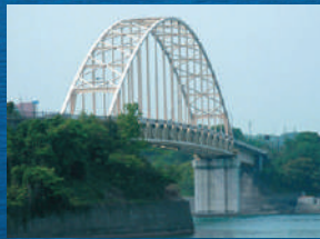
2号橋 (大矢野橋)
